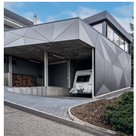
Die einzelnen Platten der Fassade wurden geklebt.
